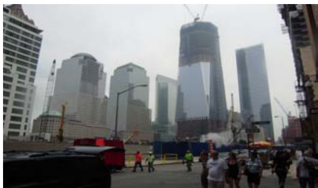
Nově budované mrakodrapy stojící na místě, kde se 11. září 2001 následkem teroristických útoků zřítily „Dvojčata“ a o život přišlo desítky tisíc lidí. USA chce v reakci na tyto útoky postavit ještě vyšší budovy, než byla ona „Dvojčata“.
